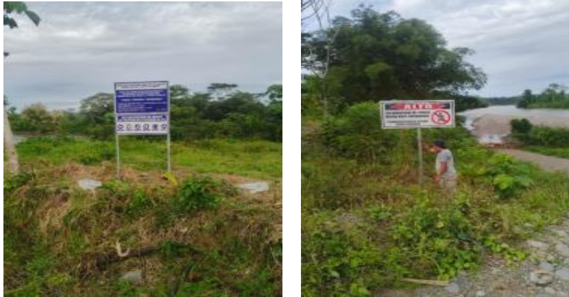
Fotografía 1 y 2.- Instalación de señalización de seguridad en el área de Libre Aprovechamiento para la Obra Pública “Fano I, Código 100000661”
